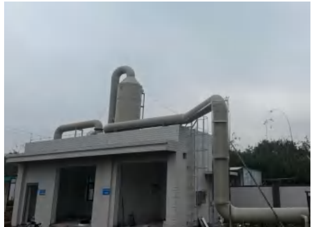
一般固废间、无害化处理间废气收集管道
