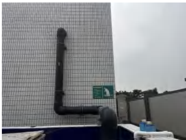
综合废水排放口
