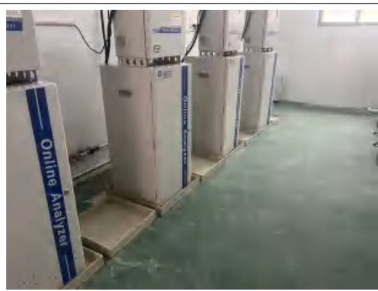
在线监测设备加托盘图片
