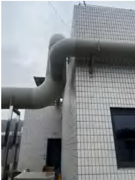
污水处理站废气收集管道
