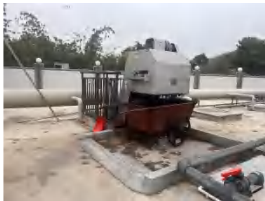
现场格栅及运输车辆清洗后图片
