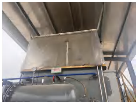
现场污水处理站气浮机加软帘图片
