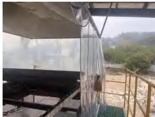
现场污水处理站气浮机加软帘图片
