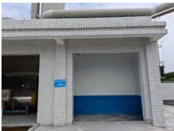
一般固废暂存间
