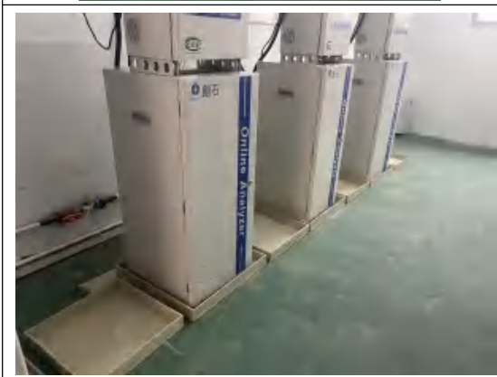
在线监测设备加托盘图片
