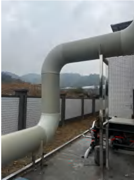
污水处理站废气收集管道
