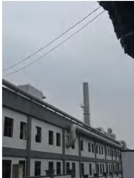
一般固废间、无害化处理间废气收集管道
