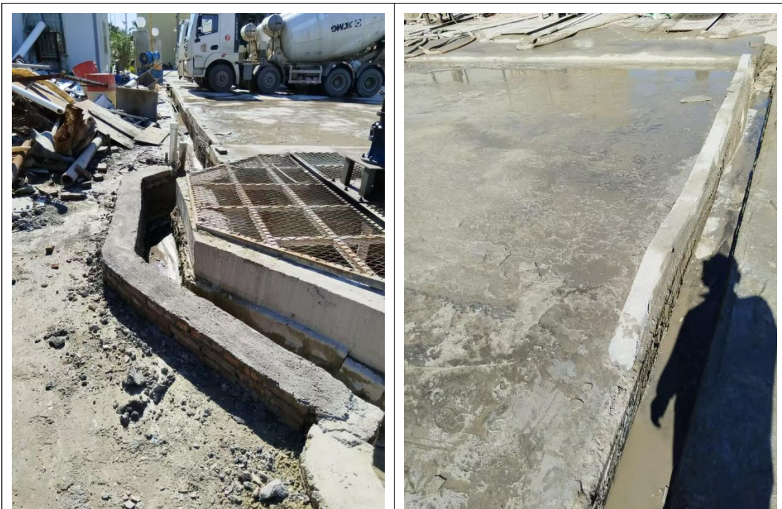
雨水沟及围堰
